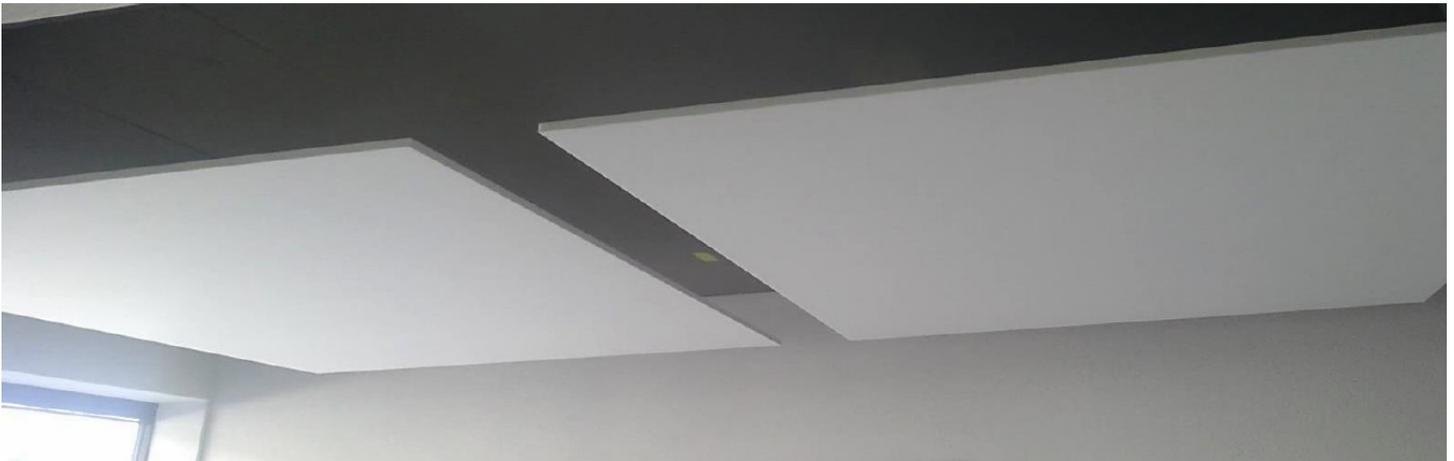
Die rahmenlosen Baffel und Segel verfügen über eine kompakte Oberfläche, sind leicht, eigenstabil und entsprechen der höchsten Absorptionsklasse (A).
