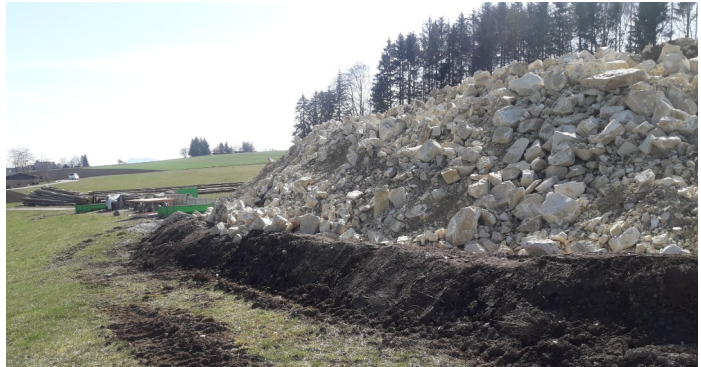
Abbildung 17: Über vier Meter hohe Häufen mit Schotter und anderem Baumaterial im Zentrum des Geltungsbereichs, südlich im Hintergrund befindet sich der Waldrand. (Aufnahme vom 29.03.2021).
