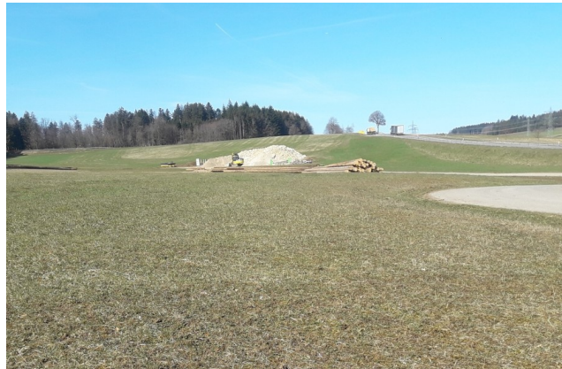
Abb. 5: Blick Richtung Westen auf das Plangebiet mit den Wiesenflächen, Baustofflager und Holzablageplatz (Aufnahme vom 29.03.2021).
