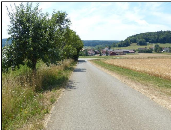
Blick nach Südosten auf den asphaltierten Weg (Flst. Nr. 342)
